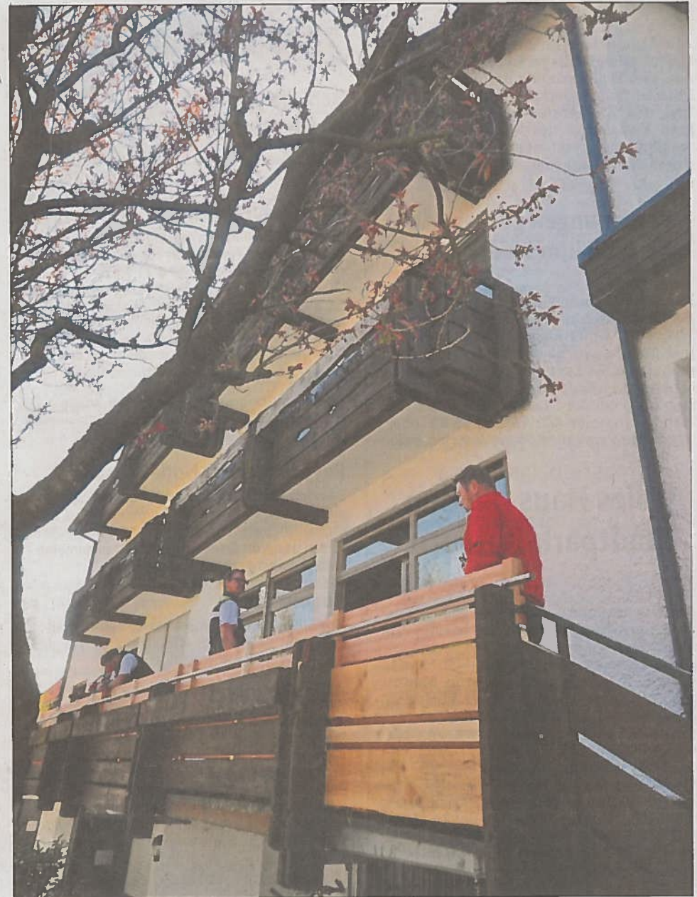
Wie man sieht, wird die Balkonbrüstung mit neuen Brettern derzeit ertüchtigt.
